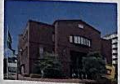
1996年(平成8年)竣工 広仁会会館 広島大学医学部キャンパス内
